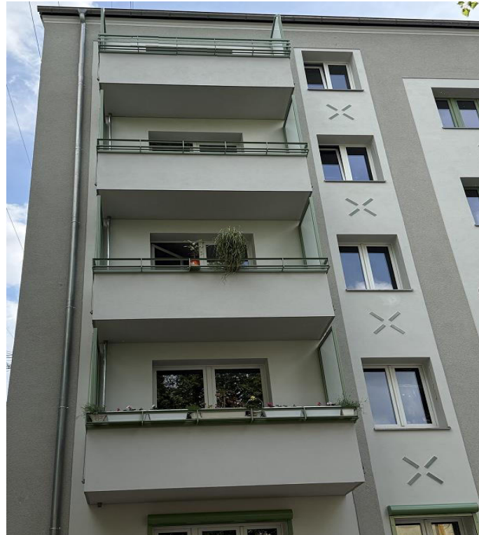
Fertiggestellte Balkone Baumbachstraße 9
