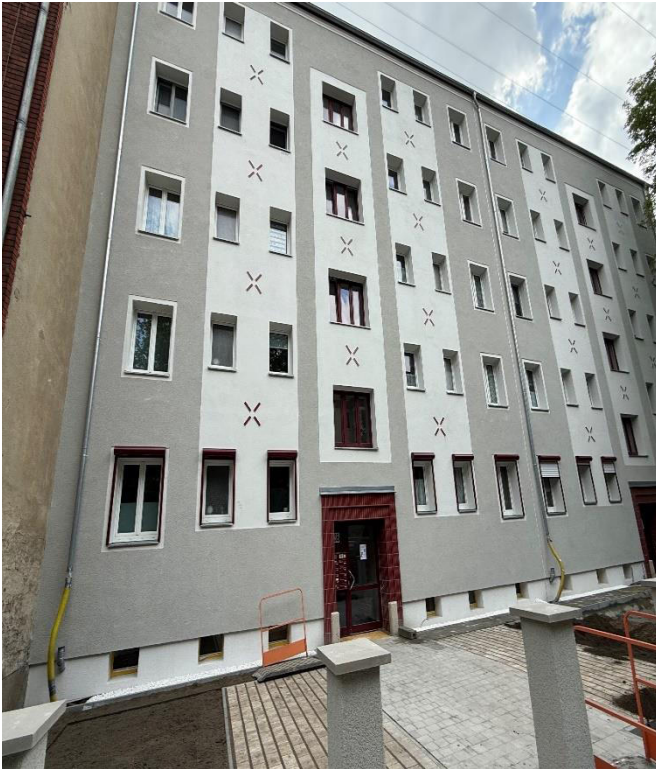
Zugang Eschengraben 38 – Fahrradabstellflächen
