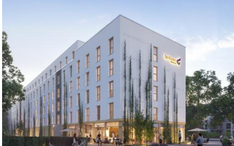
Sewanstraße (232 Betten) vom 15.01.2025 bis 14.02.2025 mit Wärmepumpe
