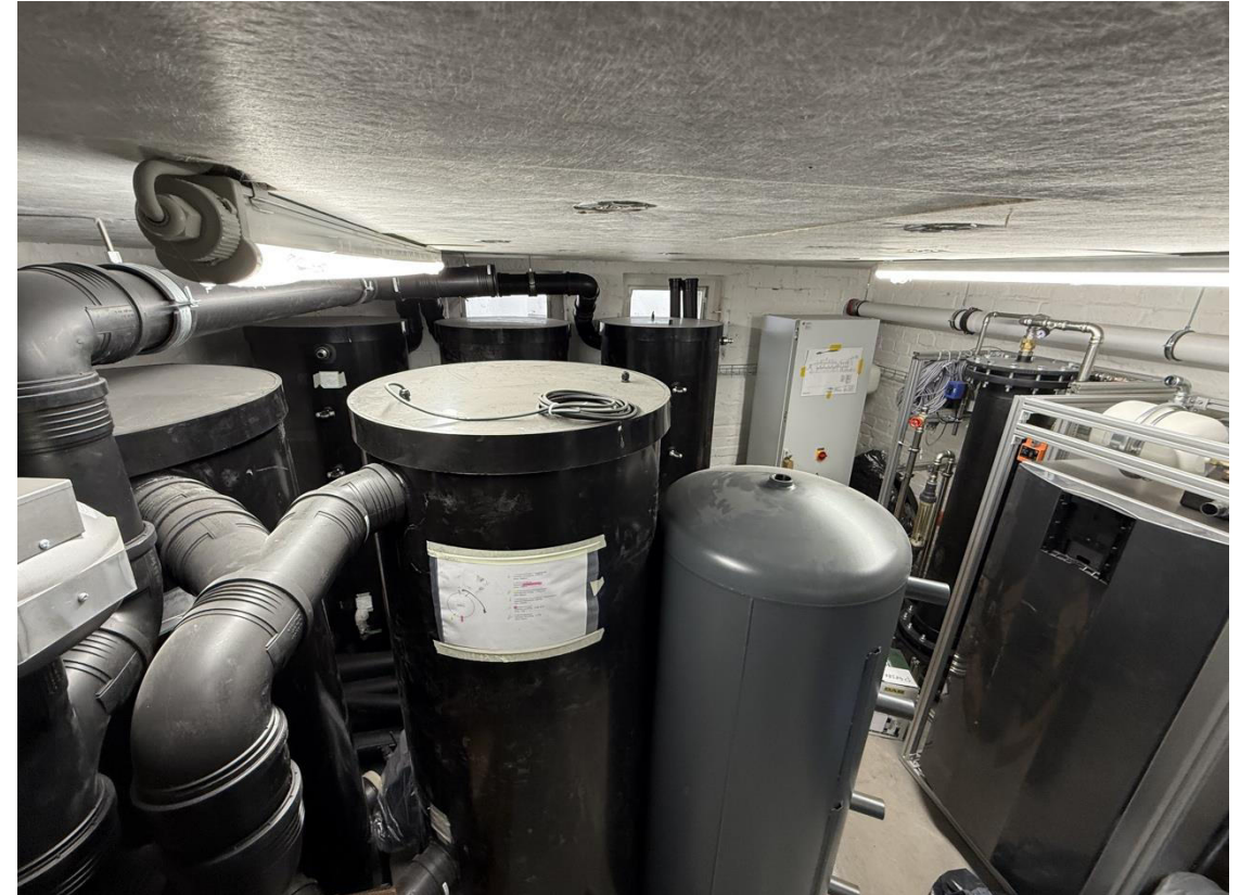
Wasserkreislauf/Installation Grauwasserrecyclinganlage im Keller Baumbachstraße 8
